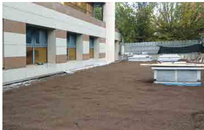
Posa dello strato drenante in argilla espansa Leca 3-8 e del LecaGreen estensivo tramite pompaggio.
