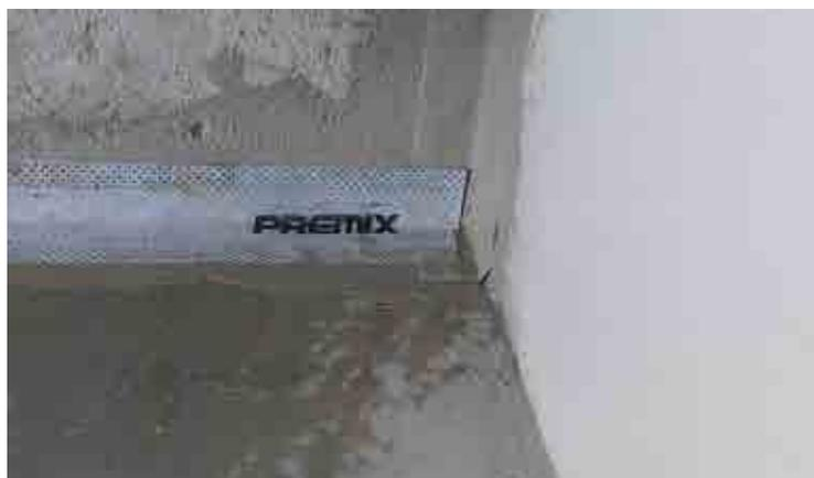
Impermeabilizzazione dei giunti perimetrali con Premelastic Angolare e Premelastic Bandella posati con uno strato di Premelastic Mono.
