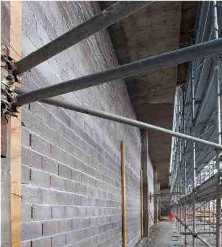
Lecablocco Bioclima 30x20x25 da intonaco utilizzato per la realizzazione delle pareti esterne.
