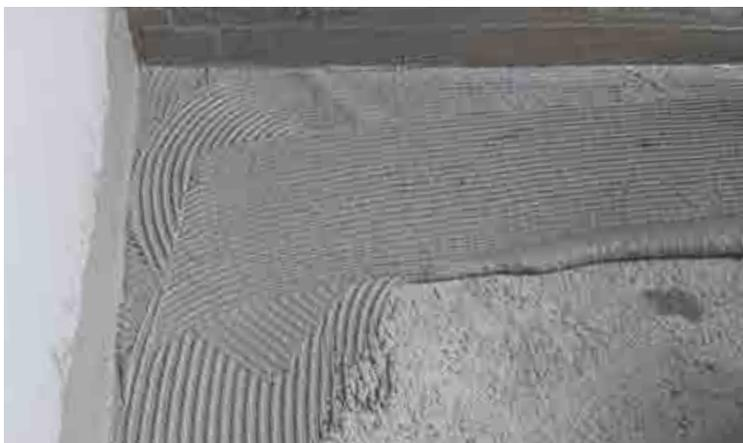
Posa del primo strato di Premelastic Mono con spatola dentata. Spessore di applicazione massimo 2 mm per strato.
