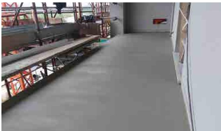
Posa del secondo strato di Premelastic Mono prima della posa delle piastrelle in ceramica per esterno.
