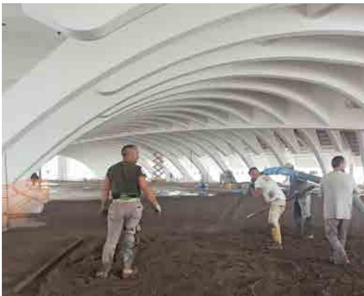
Lo strato di alleggerimento in argilla espansa Leca 2-3 cementato è stato pompato direttamente in opera permettendo la realizzazione dello strato delle pendenze in tempi rapidi.
