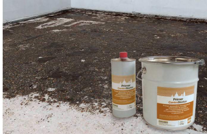
Preparazione del supporto con Primer CentroStorico.
