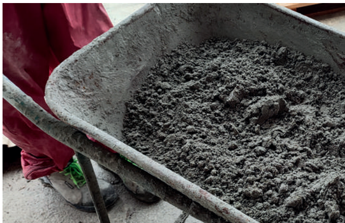
QuotaZero è un massetto a consistenza terra umida preparabile con le normali attrezzature di cantiere quali betoniere, mescolatori planetari, impastatrici a coclea anche in continuo.
