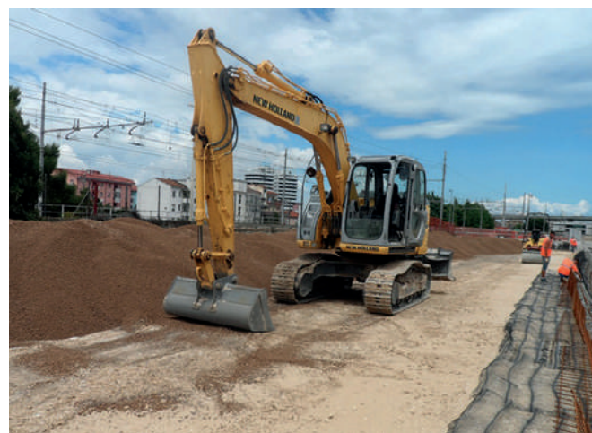
Pescara Porta Nuova - Rilevato ferroviario
