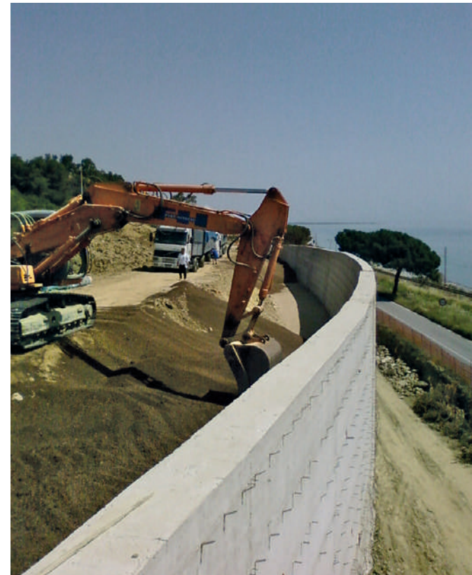
SS 106 Ionica - Riempimento dietro muro di sostegno.
