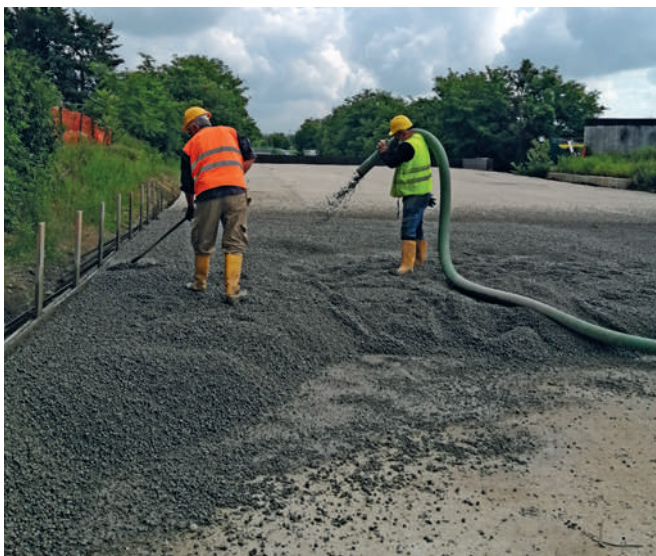
Leca cementata sopra galleria artificiale a Monza.
