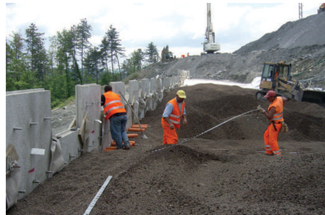
Variante di Valico Autostrada del Sole - Rilevato stradale
