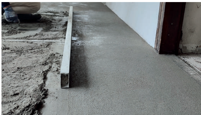
QuotaZero non richiede l'inserimento di alcuna rete di rinforzo e si posa con le normali tecniche dei sottofondi.
