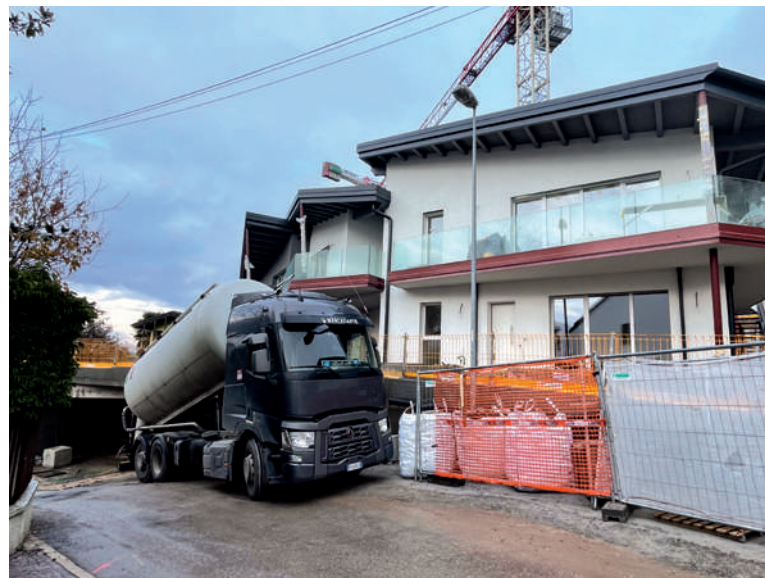
Il pompaggio del materiale avviene attraverso speciali mezzi cisternati che permettono di pompare il materiale fino a 80-100 m di distanza.
