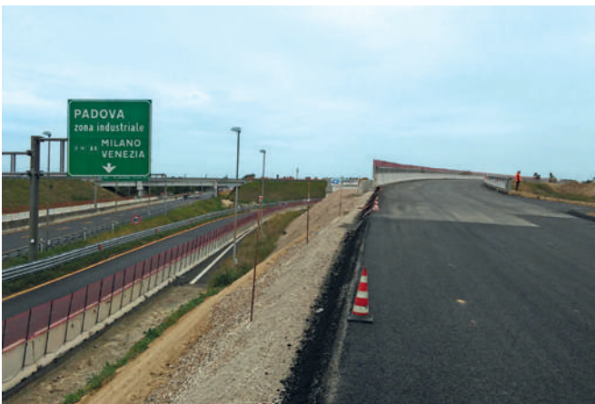
A4-A13 - Rilevato stradale
