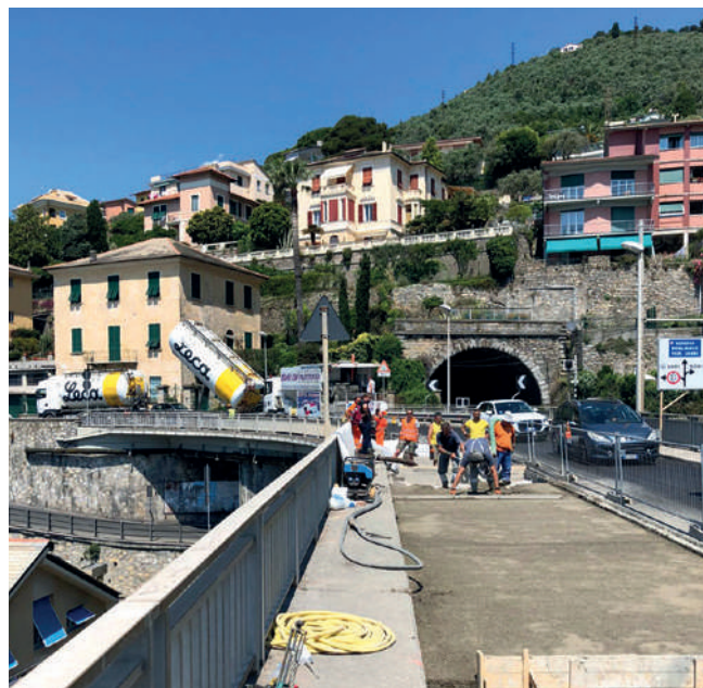
Sottofondo stradale alleggerito su viadotto a Sori (GE).
