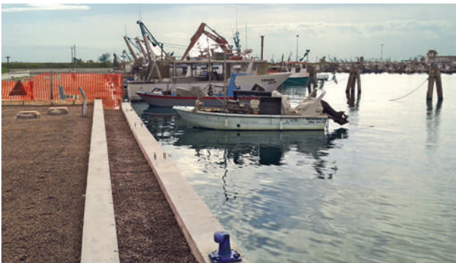
Ampliamento banchina porto di Goro (FE).
