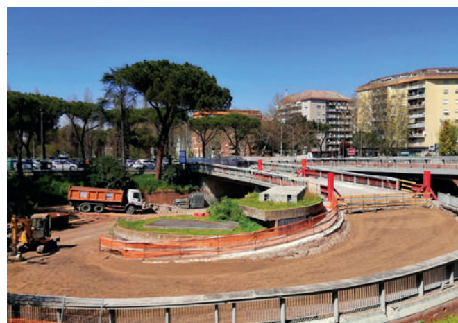
Roma EUR - Rilevato stradale
