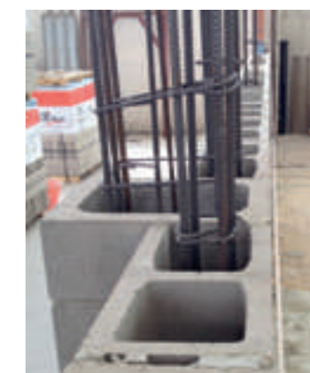
Particolare Lesena strutturale.
