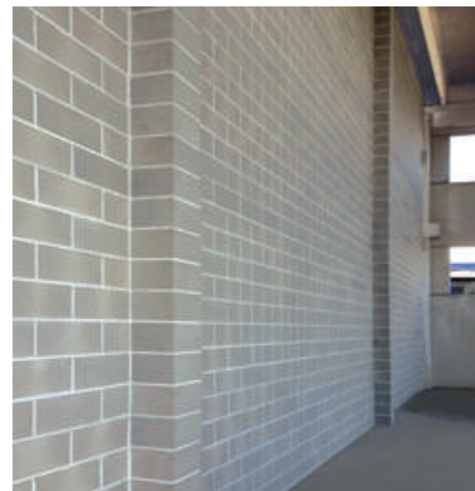
Pareti in Lecablocco Tagliafuoco Facciavista in un edificio industriale.
