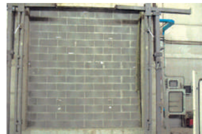
Foto della parete di prova (lato esposto al fuoco dopo la prova).
