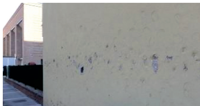
Isolamento a cappotto tradizionale danneggiato in superficie. Facilità di posa del Lecablocco MuroCappotto.
