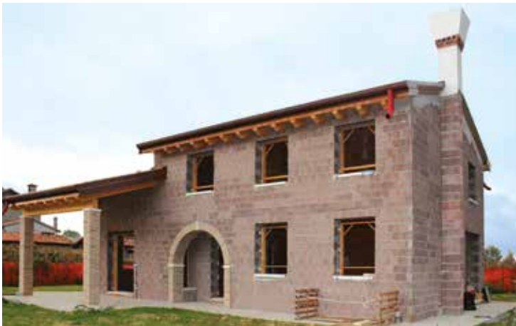
Edificio residenziale in Bioclima Zero18P.
