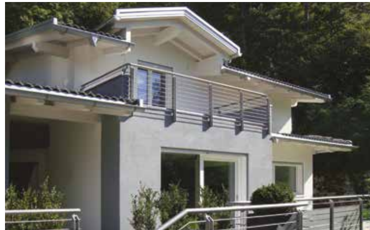
Edificio residenziale in Bioclima Zero27P.
