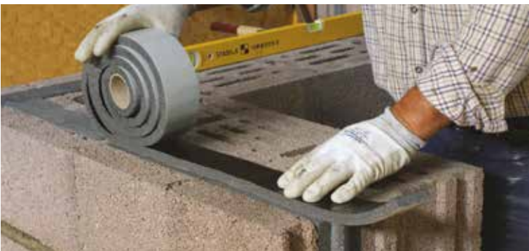
Posa della striscia isolante adesiva.
