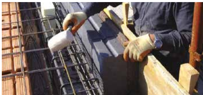
Posa della tavella isolata in corrispondenza del cordolo di solaio.
