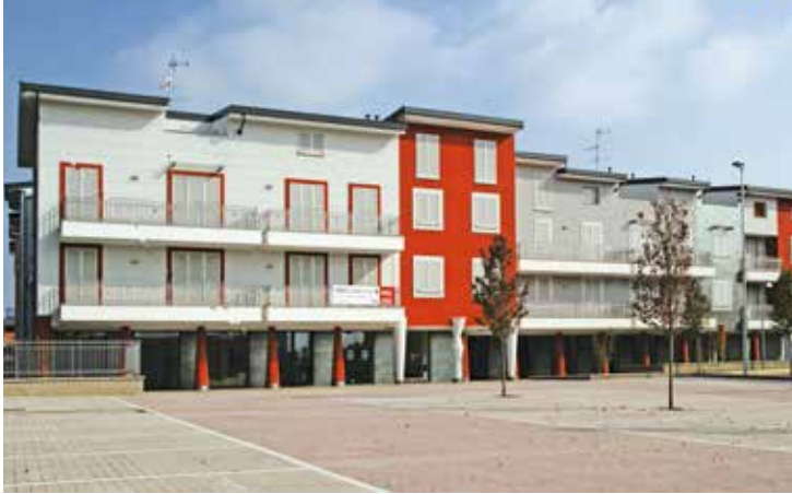
Edificio residenziale in Bioclima Zero27P.
