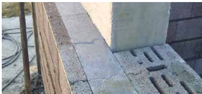
Parete di tamponamento con Lecablocco Bioclima Zero18P (setti in c.a. di spessore 25 cm).
