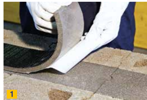
Posa della striscia isolante e stesura della malta.
