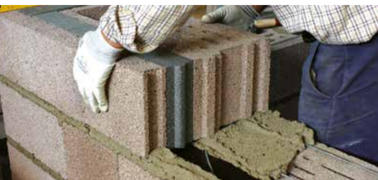
Inserimento del traliccio ogni due corsi e posa del corso successivo.
