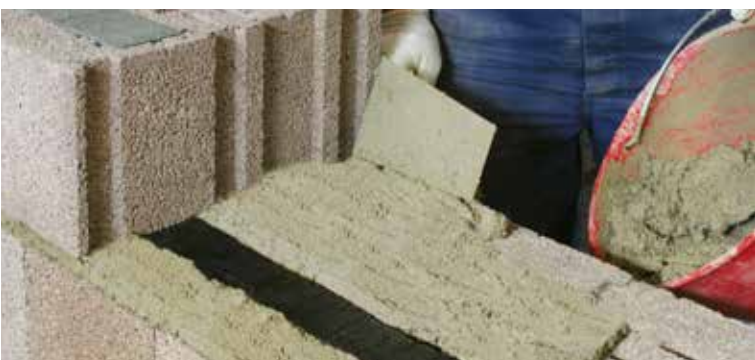
Posa della malta su due strisce.
