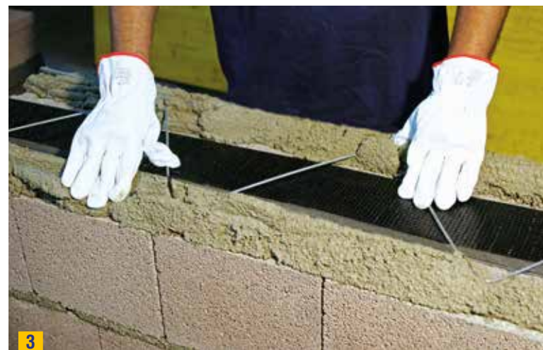
Posizionamento del traliccio metallico Murfor.
