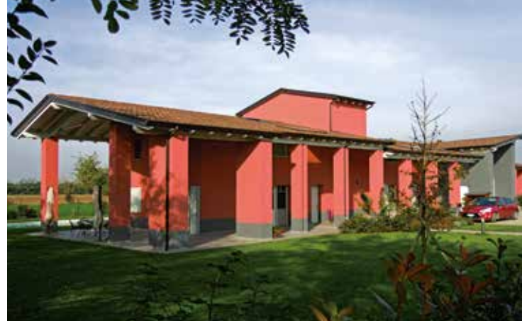
Edificio residenziale in Bioclima Zero27P.
