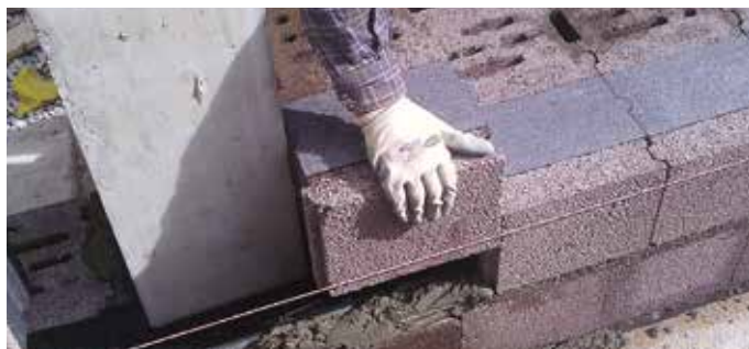
Parete di tamponamento in Lecablocco Bioclima Zero18P (pilastri in c.a. di spessore 30 cm).
