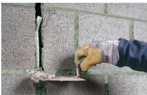
Corretto riempimento delle tracce impiantistiche.
