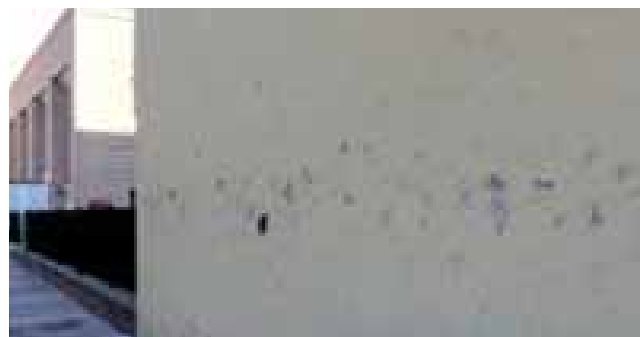
Isolamento a cappotto tradizionale danneggiato in superficie.
