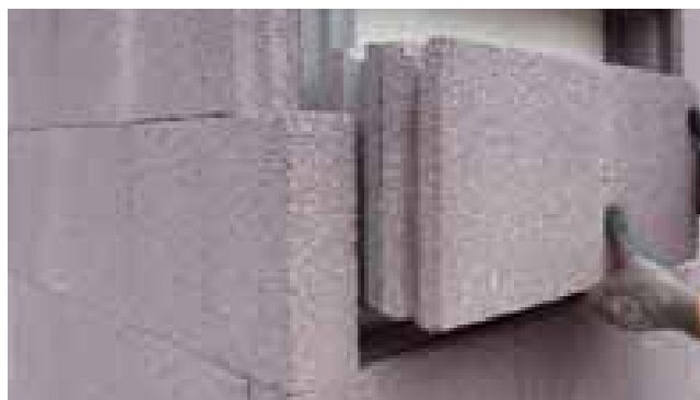
Isolamento a cappotto tradizionale danneggiato in superficie.
