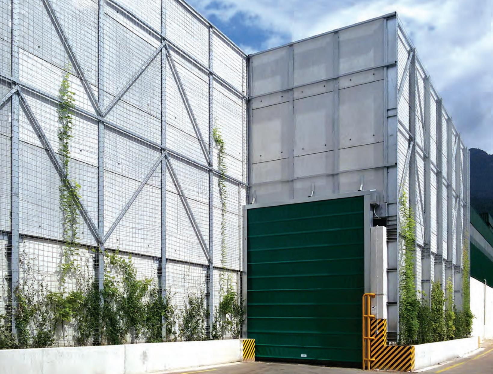
Per rendere gradevole l'aspetto posteriore della barriera e mitigarne l'impatto ambientale, sono state create grigliature in rete metallica su cui fare crescere piante rampicanti.
