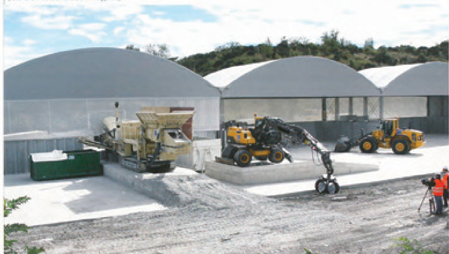
Figura 4 Area di lavorazione Gy.eco presso il sito di Sassotetto-Pesaro (foto archivio Saint-Gobain Gyproc)
