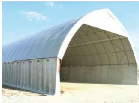
taggio e smontaggio che si riversa in un significativo risparmio di costo per metro cubo di materiale stoccato. Le pareti mobili e modulari di cui sono composti i silos consentono la ricomponibilità in altre configurazioni, la facilità di spostamento da un luogo all'altro e, nel caso sia necessario, la possibilità di modificarne la capacità contenitiva nel tempo.
